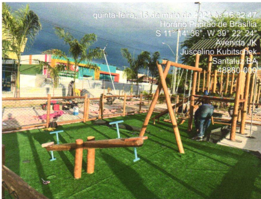
Foto 05 - Fornecimento e assentamento de Casinha do Tarzan em eucalipto tratado, com pântico de um balanço
