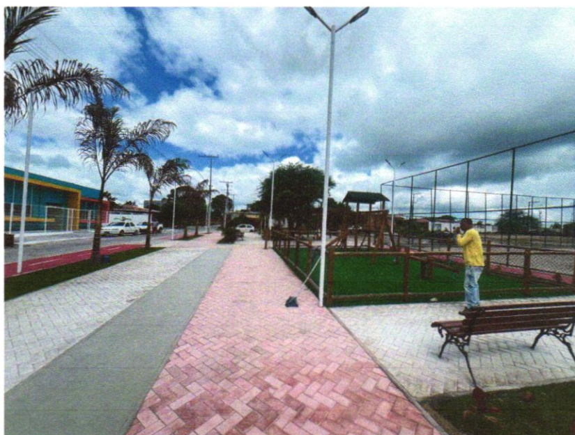
Foto 14 - Poste decorativo 2 pétalas, em aço galvanizado com difusor em vidro transparente temperado, com 3m/4m, inclusive lâmpada de led 50w
